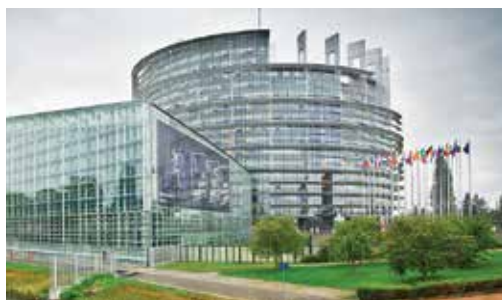
Мал. 29. Будівля Європарламенту — законодавчого органу ЄС (Страсбург, Франція)
