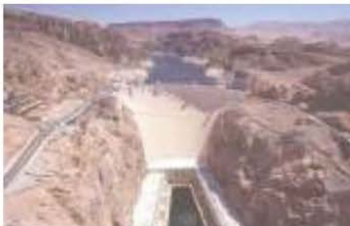
Мал. 85. Гідроелектростанція на річці Колорадо
