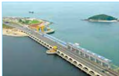
Мал. 368. Припливна електростанція в Південній Кореї
