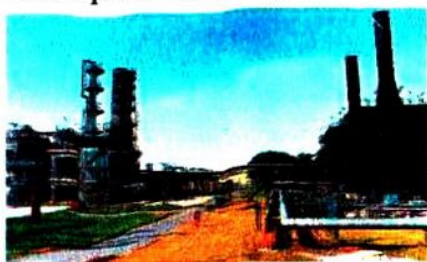
Рис. 27. Завод з підготовки транспортування природного газу (Полтавська обл.)
