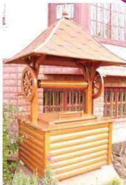
Мал. 122. Коловорот у конструкції колодязя
