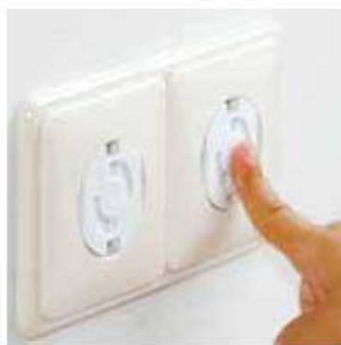
Мал. 197. Розетки захищені від проникнення сторонніх предметів
