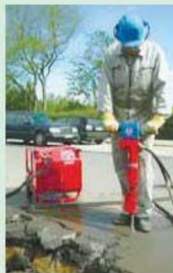
Мал. 141. Дорожні роботи з відбійним молотком
