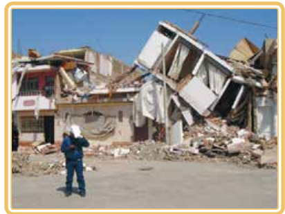
La casa caída a causa del terremoto.
