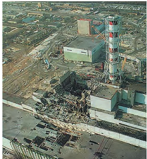
Зруйнований реактор на Чорнобильській АЕС
