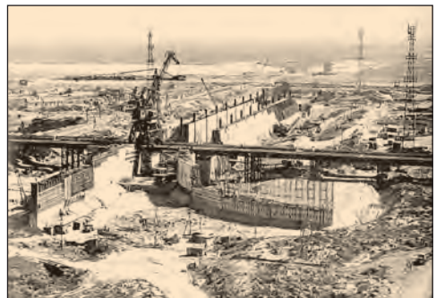
Будівництво Каховської ГЕС. 1953 р.
