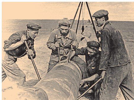
Прокладання першого магістрального газопону «Дашава–Київ». Фото. 1948 р.
