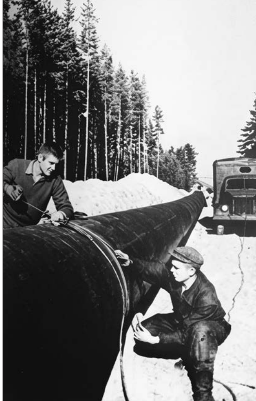
Будівництво газопроводу «Шебелинка—Острог». 1960 р.
