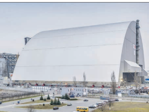
Арка безпеки над 4-м енергоблоком. 2016 р.
