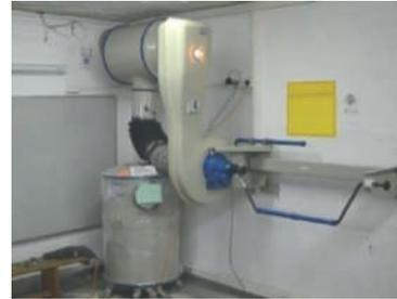
Іл. 66.5. Фільтровентиляційний агрегат
