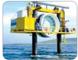
Станція, яка використовує енергію Світового океану
