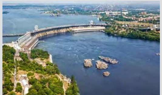
Гребля збудованої у 1930-х рр. Дніпровської гідроелектростанції, що перегороджує Дніпро й утворює Дніпровське водосховище площею 410 км 2 . Це водосховище затопило знамениті Дніпровські пороги
