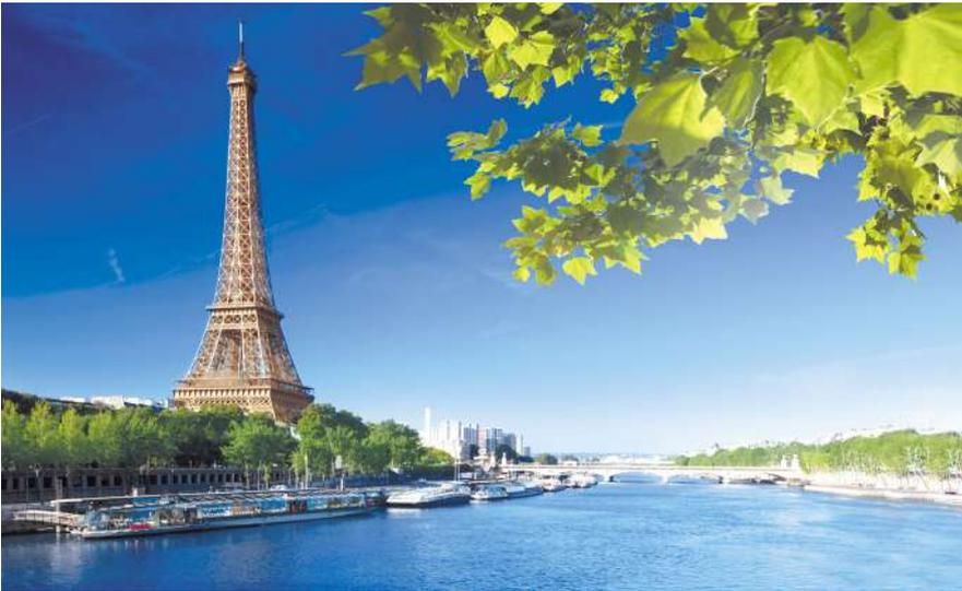
Véritable prouesse technique, la tour mesure 320,75 m avec son antenne radiotélévision et pèse 6 400 tonnes. Elle se compose de 15 000 pièces métalliques réunies par 2 500 000 rivets. La restauration de la tour est effectuée tous les 7 ans et nécessite 45 tonnes de peinture. Divisée en trois étages la tour Eiffel dispose de boutiques et de restaurants et offre un panorama splendide sur Paris et ses environs. La tour est ouverte tous les jours jusqu'à 23 heures.
