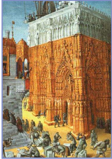
Жан Фуке. Будівництво храму. XV ст.
