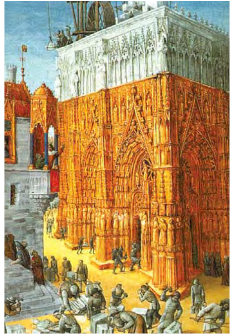
Жан Фуке. Будівництво храму (XV ст.)
