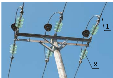
Рис. 31.2. Створення ліній електропередачі неможливе без використання провідників (1) і діелектриків (2)
