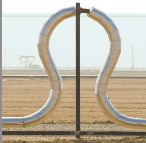
Рис. 11.5. Щоб трубопроводи для передачі гарячої води не пошкоджувалися внаслідок зміни температури, конструктори створюють розширювальну петлю
