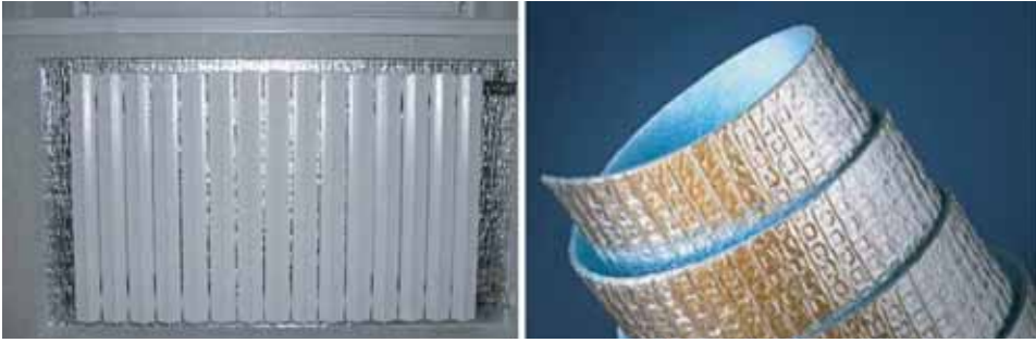
Рис. 6.10. Тепловідбивний екран із порилексу
