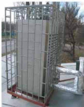
Тепловий насос «повітря – рідина» IVT, 17 кВт
