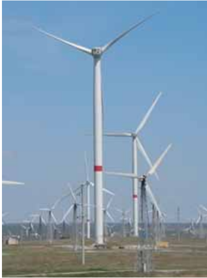
Рис. 17.3. Вітрові турбіни Новоазовської вітрової електростанції
