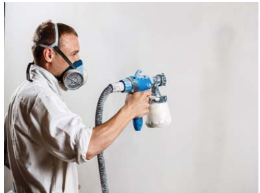
Мал. 16.1. Фарбування стіни за допомогою пульверизатора
