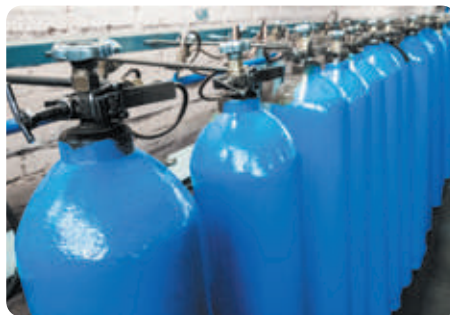
Балони з киснем, пофарбовані в синій колір
