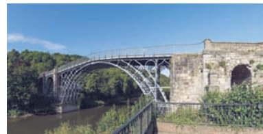
Сучасний вигляд першого у світі чавунного моста через ріку Северн. Відкритий у 1781 р.
