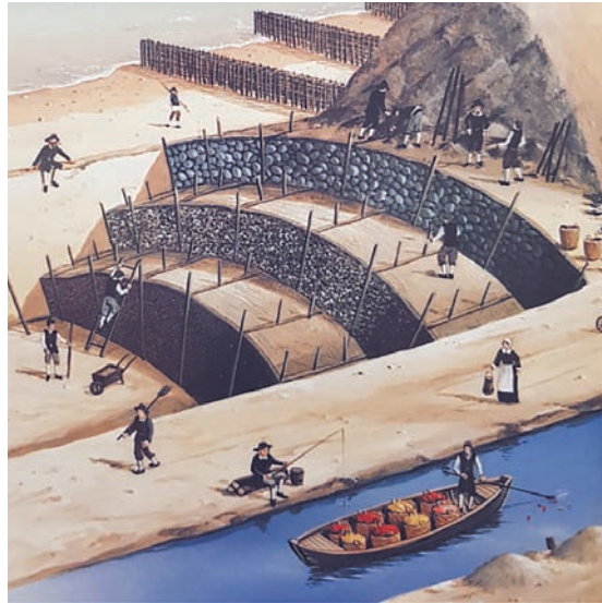
Будівництво дамби, яка відгороджує низини від моря
