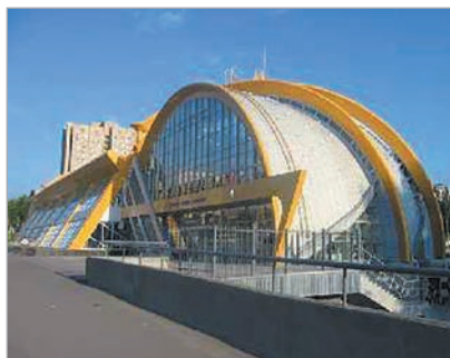
Вокзал на станції Каравасів Дачі в Києві. Арх. В. Куц, 2005 р.
