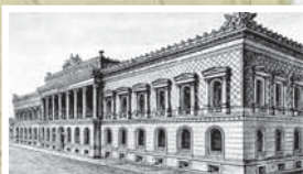
Будівля Імперського банку Німеччини. Гравюра XIX ст.
