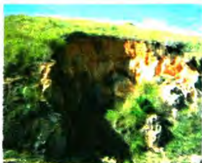
Мал. 149. Ерозія ґрунту.
