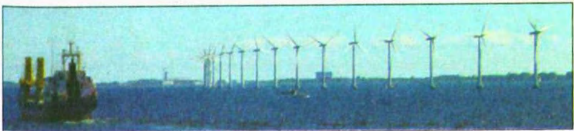
Вітрова електростанція. Данія
