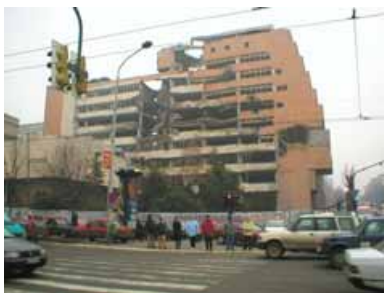
Мал. 11. Зруйнована будівля у Белграді
