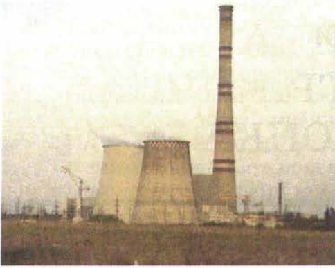
Мал. 196. Теплова електростанція
