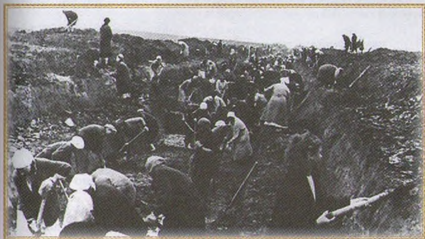
Робота над будівництвом оборонних споруд
