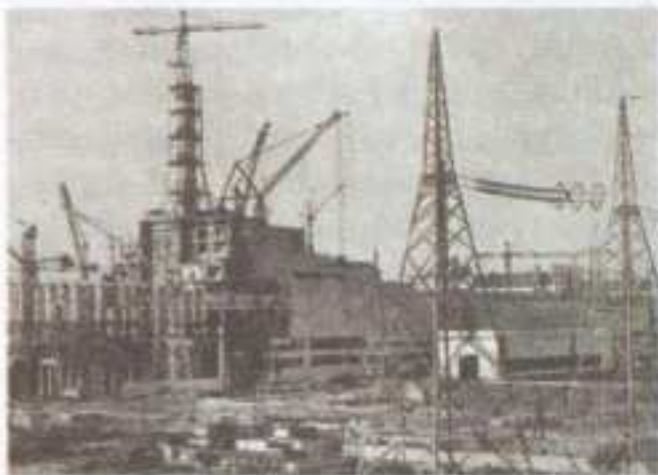
Будівництво першого енергоблоку ЧАЕС. 1978 р.
