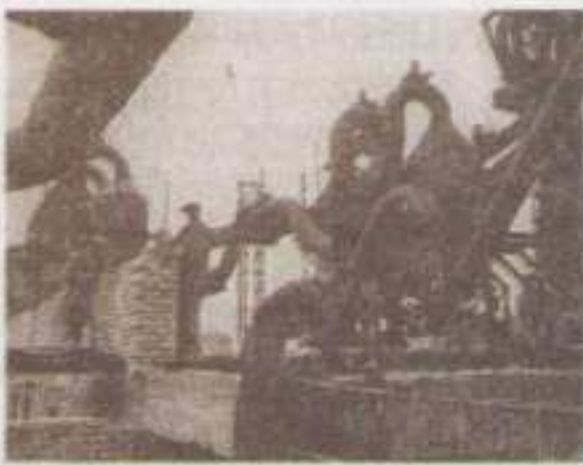
Спорудження доменної печі № 4 на Маріупольському заводі «Азовсталь». 1945 р.
