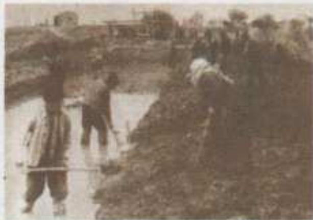
Будівництво іригаційної системи. Одещина. 1949 р.
