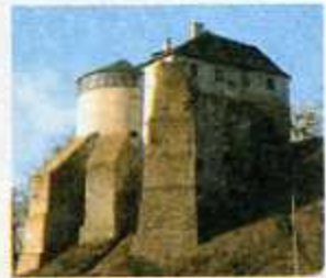
Мурована вежа Острозького замку
