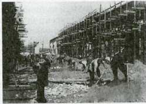
Будівництво Новокраматорського машинобудівного заводу. 1932 р.
