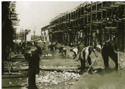
Будівництво механічного цеху № 6 на Новокраматорському машинобудівному заводі. 1932 р.
