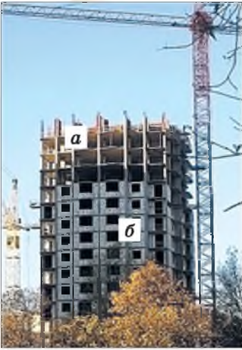
Будівництво багато-поверхового будинку: а — каркас будинку, спорудження опорних стін; б — наступний етап — закладання цеглою зовнішніх стін
