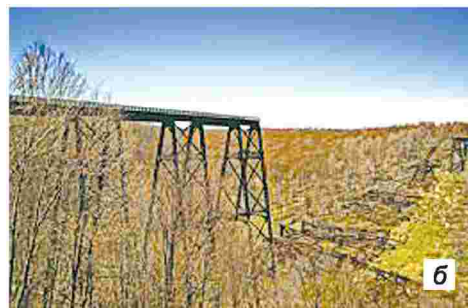
Мал. 152. Наслідки ржавіння: а – зруйнований Срібний міст у Західній Вірджинії; б – зруйнований міст Кінзу в Пенсильванії
