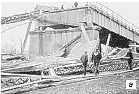
Мал. 152. Наслідки ржавіння: а – зруйнований Срібний міст у Західній Вірджинії; б – зруйнований міст Кінзу в Пенсильванії
