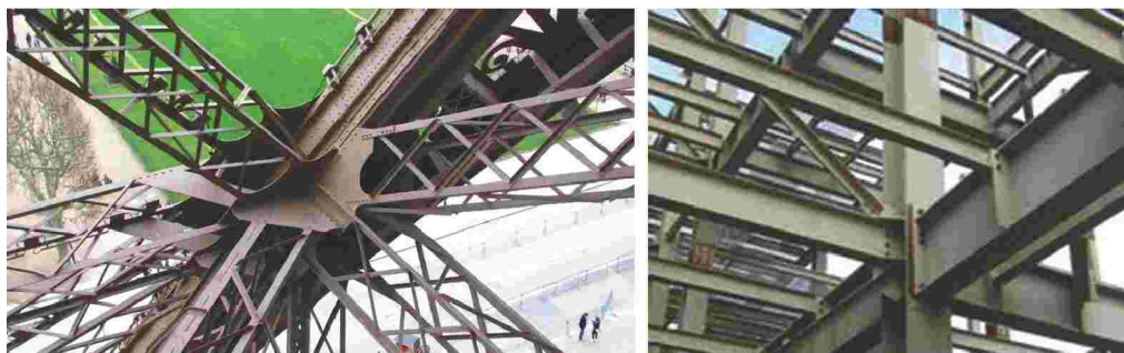
Мал. 114. Застосування заклепкових з'єднань
