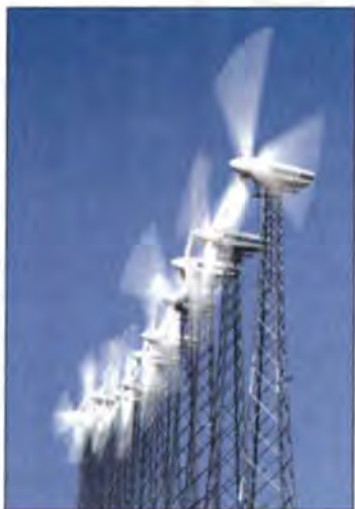
Мал. 13. Вітрогенератори на електростанції
