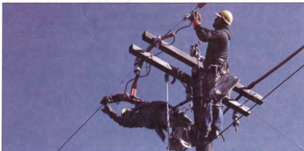
Мал. 107. Монтаж високовольтної мережі
