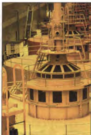
Мал. 12. Гідрогенератори на ГЕС
