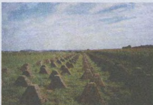
Іл. 17.4. Залізобетонні пірамідальні протитанкові перешкоди
